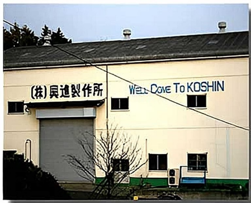
製缶組立工場
